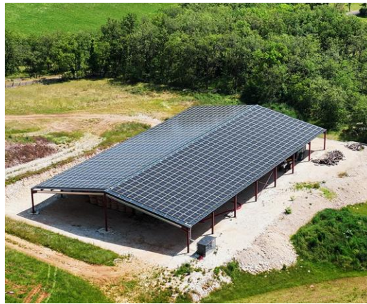
Crédit photo APEX - Hangar agricole à Martel (46) – 357 KWc
